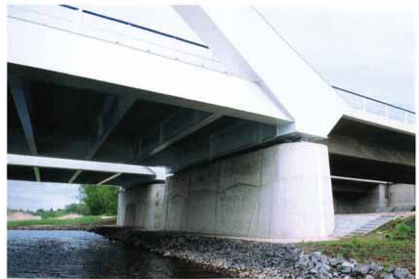
Seitenansicht Pfeiler aus Richtung Süd
