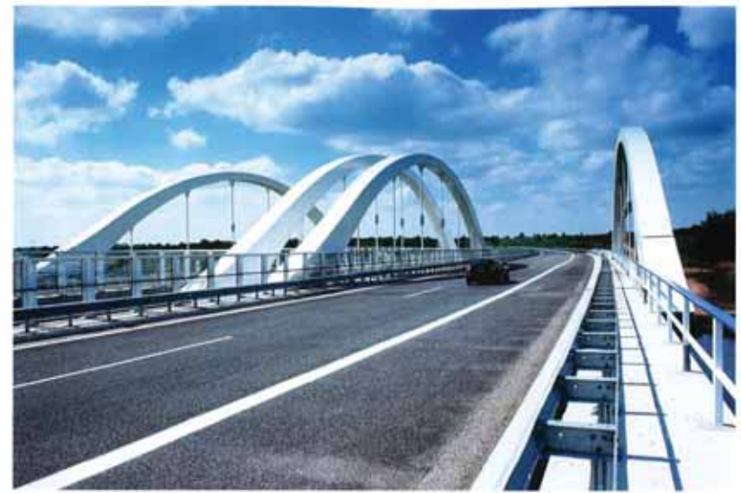
Blick von der Fahrbahn
