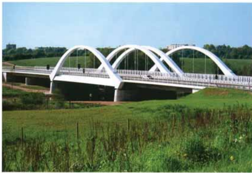
Gesamtansicht aus Richtung Süden
