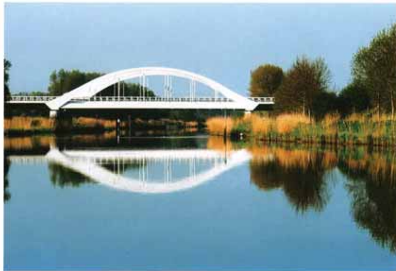
Ansicht aus Richtung Ost
