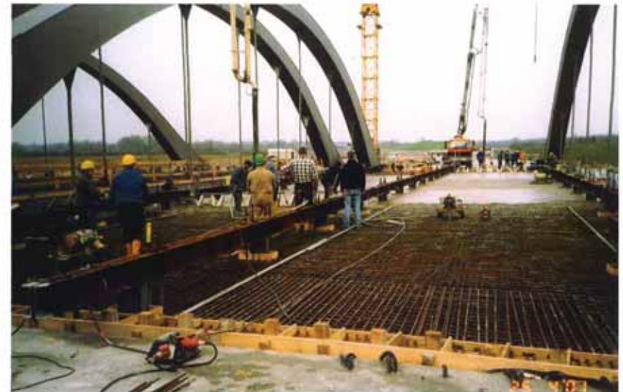
Betonieren Fahrbahnplatte der Kanalbrücke
